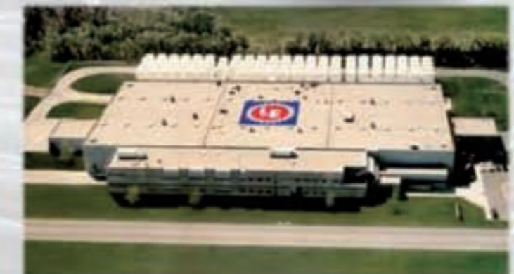
Planta Modelo de LE en Wichita, KS. Sus oficinas centrales están en Fort Worth, TX, con dos depósitos para distribución ubicados en Knoxville, TN y Las Vegas, NV. LE también se encuentra presente en todo el mundo a través de su red de distribuidores en más de 50 países.
